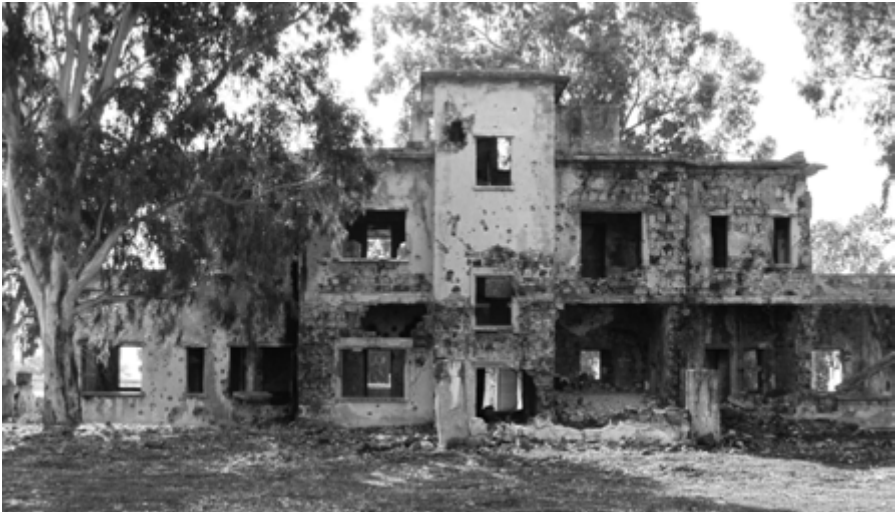
Abb. 2: Nordfassade des ehem. französischen Zollpostens. Foto: Edith Tsouri, 2013
